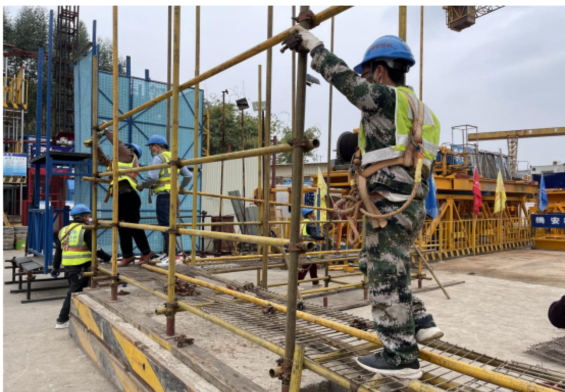
学员在进行脚手架搭设实操
