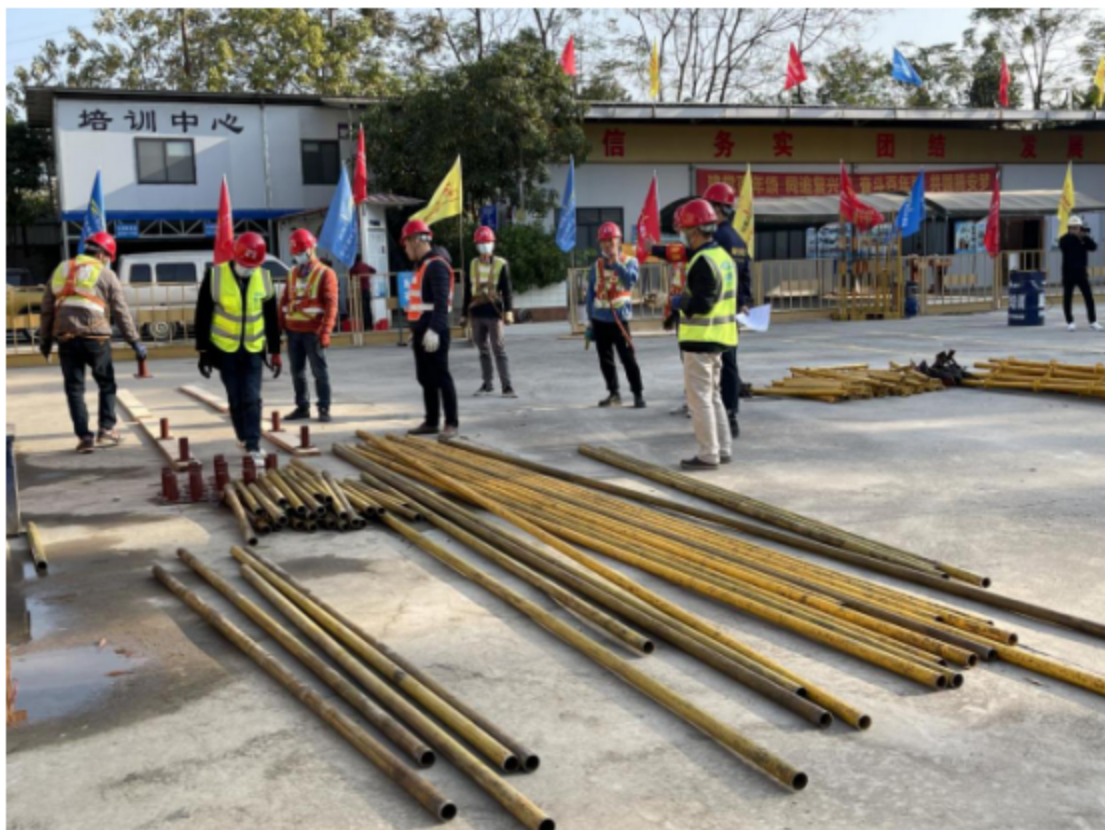
学员在进行脚手架搭设实操
