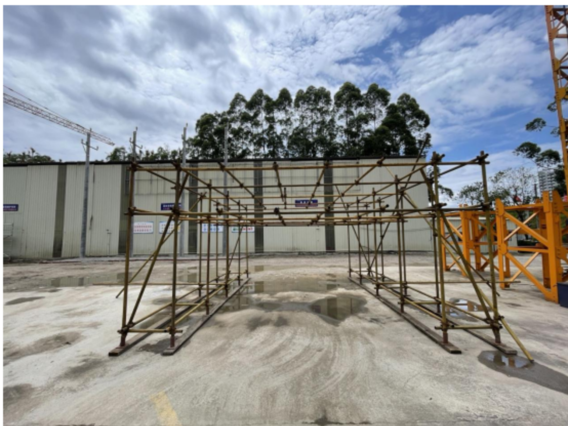
双排落地跨越式钢管脚手架
